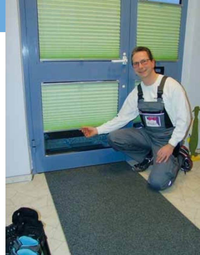
Sauberlaufzone und Plissee-Sonnenschutz im Eingangsbereich
