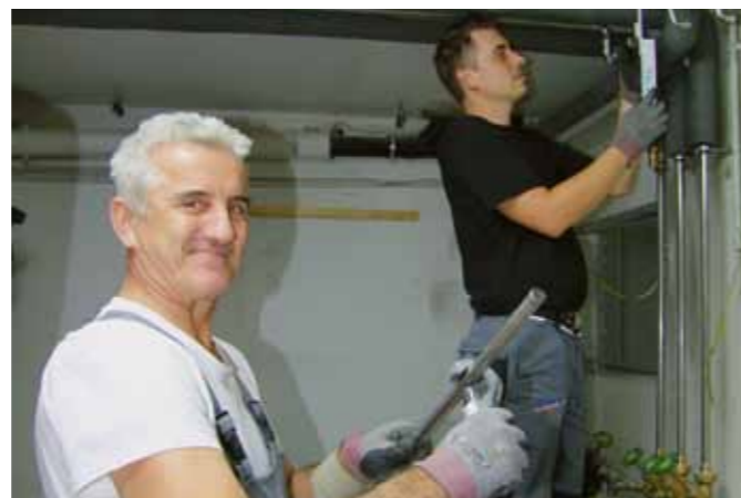
Andreas Pajak und Andreas Richter bei der Wasserinstallation.
