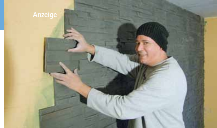
Eckert Fliesen verlegt eine Riemchenwand.
