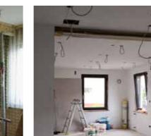
Thomas Schmid stützt die Decke ab, bricht Zwischenwände heraus und zieht Stahlträger ein. Karsten Eckert verlegt Dünnbettheizmatten sowie Feinsteinzeugfliesen und gestaltet Bad und Dusche
